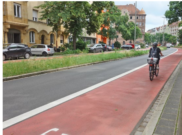
Der Radstreifen in der Pillenreuther Straße wurde verbreitert und rot eingefärbt.
