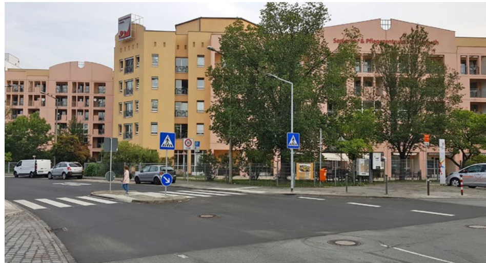
Fußgängerüberwege können das Queren der Straße erleichtern.
