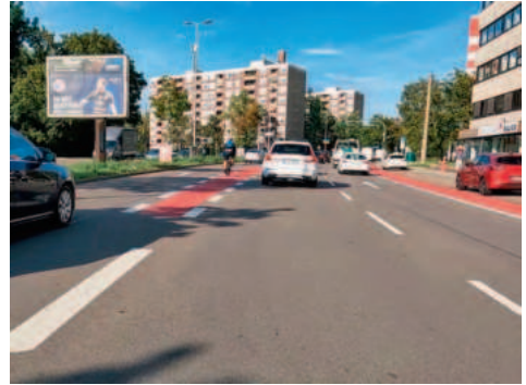
Ein Radstreifen in Mittellage zwischen Linksabbieger- und Geradeausspur (von der Äußeren Bayreuther Straße in die Ziegelsteinstraße)
