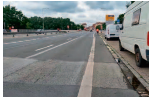
Unebene Fahrbahn mit unterschiedlichem Belag und Enge vor der Theodor-Heuss-Brücke
