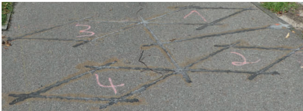
Induktionsschleife für eine Zählstelle (Foto: H. Roß)
