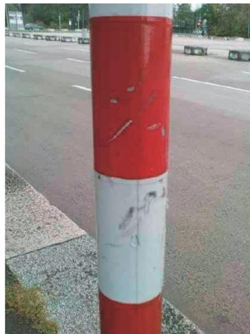
Die Spuren zeigen: Gegen diesen Pfosten sind Fahrrad-Lenker gestoßen
