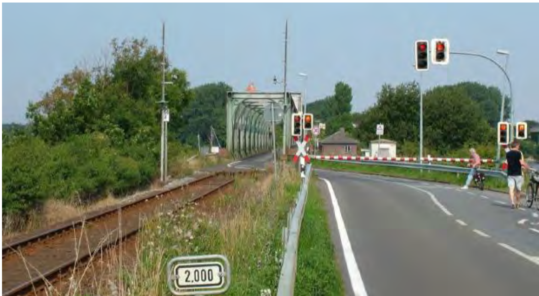
Abbildung 17: Schrankengeregelte Mischnutzung der Eisenbahnbrücke bei Lindaunis
